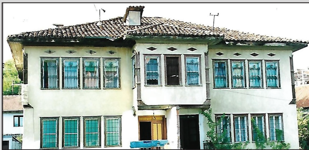
Kuća Osman-age Trtovca na Paricama, ul. Sarajevska br. 6 u Novom Pazaru
